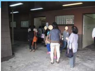
旧トイレ状況
